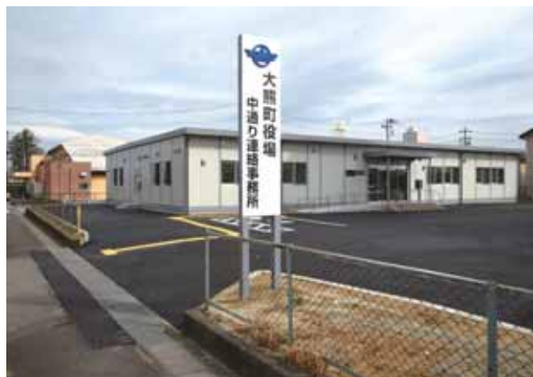
中通り連絡事務所 (二本松市から郡山市へ移設)
