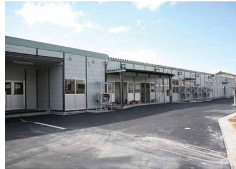
プレハブ造りの大熊中仮設校舎
