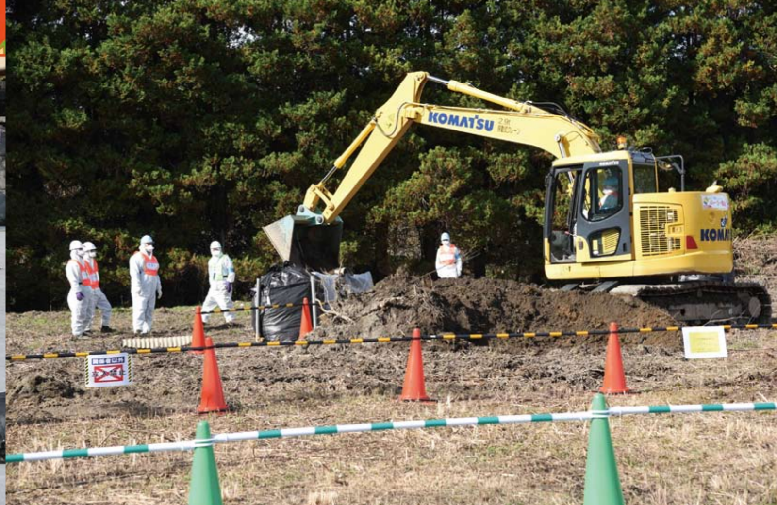
上:国が開いた中間貯蔵施設の住民説明会 下:町内で始まった中間貯蔵施設の本格施設工事
