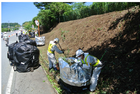
6号国道沿いで行われている除染
