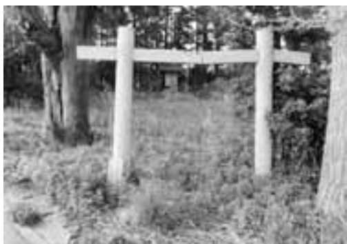
諏訪神社(熊川) ほぼ全壊。拝殿部分が流失。本殿のみ残っている状態。 半壊
