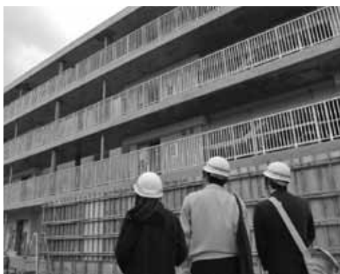
完成間近な古川町団地
