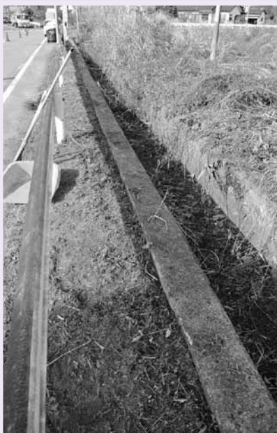
除染を終え、きれいになった道路わき
