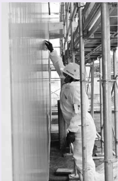
施設の壁を丁寧にふき取る作業員
