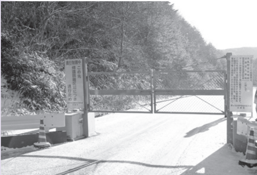
中屋敷地区に設置されているゲート
