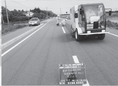
道路除染（同時吸引高圧洗浄車）
