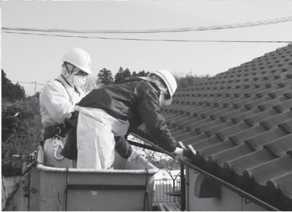
家屋除染（軒樋洗浄）
