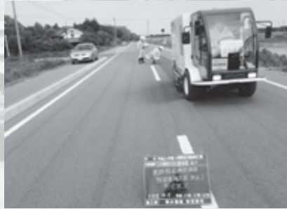
道路除染（同時吸引高圧洗浄車）
