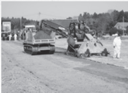
農地除染（表土削り取り）
