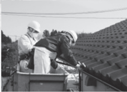
家屋除染（軒樋洗浄）
